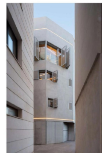
FACHADA EDIFICIO EN MORTERO GEOLITE ACABADO HORMIGÓN
